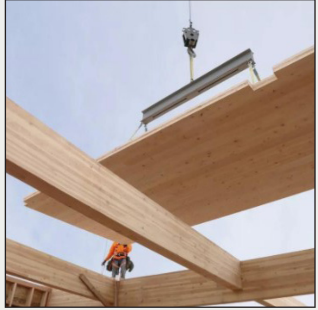
Glulam kolon-kiriş sistemi üzerinde yerleştirilen CLT panel.
